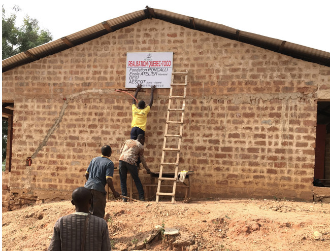
Le travaux continuent
